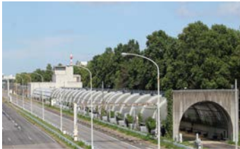
写真-1 実大トンネル実験施設
