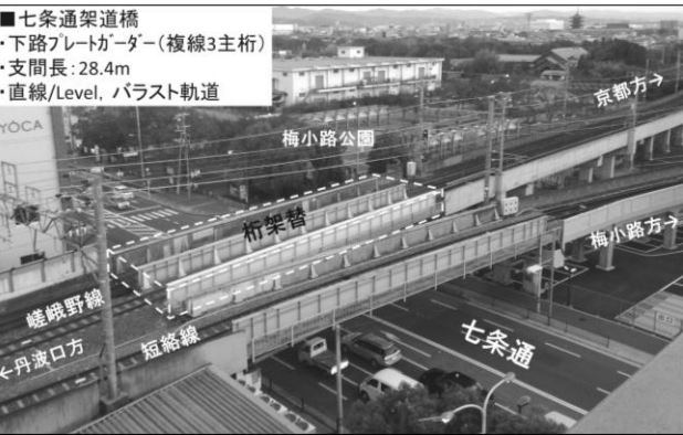
図－４ 七条通架道橋の概要
