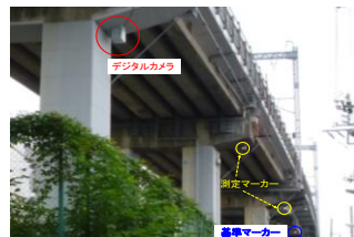
図 4-2 設置状況写真
