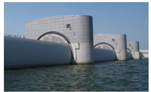
写真5 曲線を用いた堰柱部
