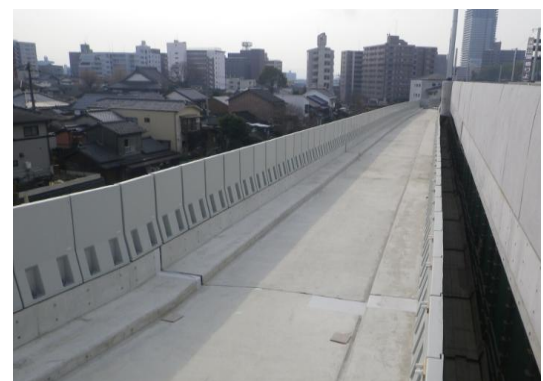
（写真－5 上床版（完成））
