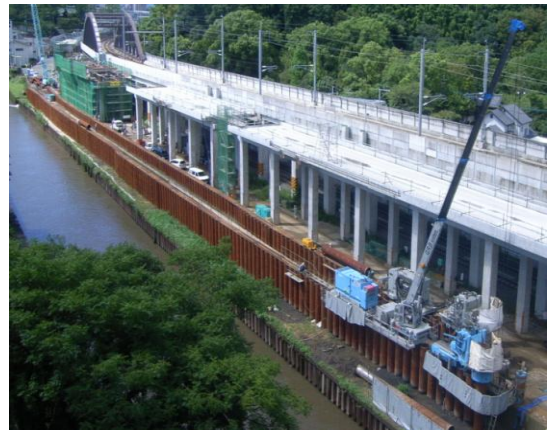
（写真－2 ジャイロパイラー施工）
