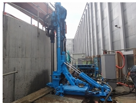
図-4 ケーソン背面削孔の施工状況
