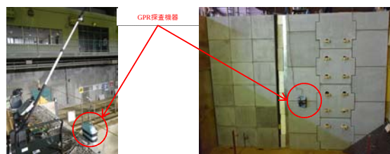
写真-2 非破壊検査による診断手法の適用性の検討 4)
