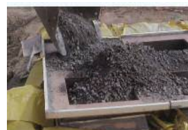
③一定量の中詰材を投入・閉口
