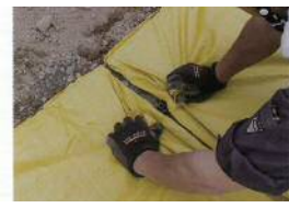
②ロックジョイントで特殊土嚢を接続
