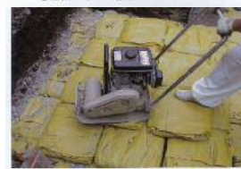
④各段ごとに転圧して積上げる
