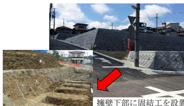
写真-2 地すべりの変形被害の復旧対策事例
