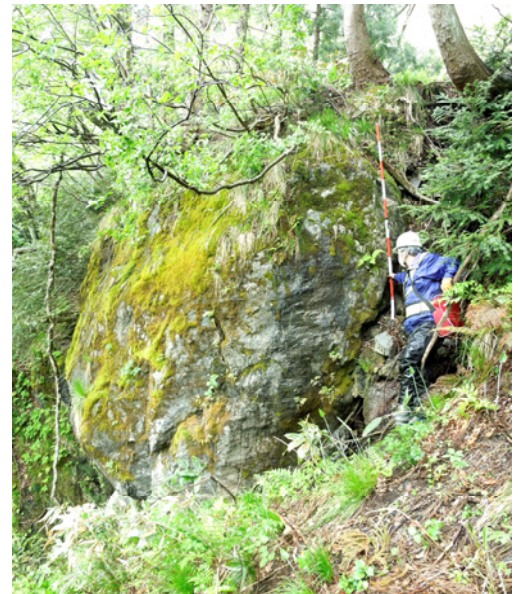
写真-1 調査対象の巨岩塊の状況
