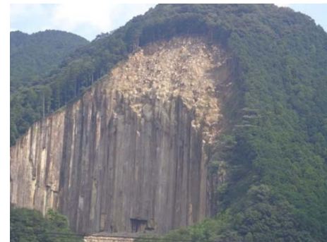
写真1 柱状節理が発達した岩盤の崩壊
