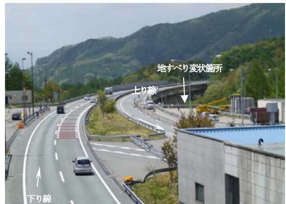
写真-3 上り線1車線、下り線2車線開放状況
