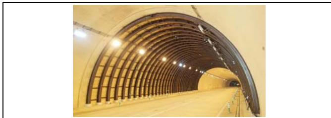
写真-2 鋼アーチ支保工による補強状況
