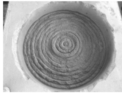
写真-3 全断面型の掘削状態
