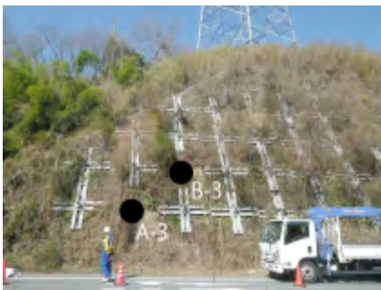
写真-1 現地状況
