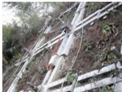
写真-2 荷重計設置状況
