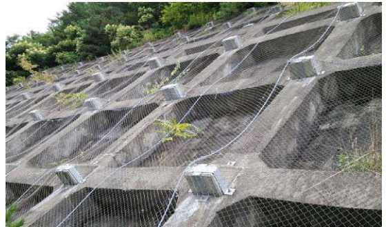
写真-1 旧タイプアンカー打設のり面
