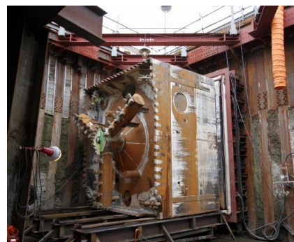
写真 3 第一函体到達状況
