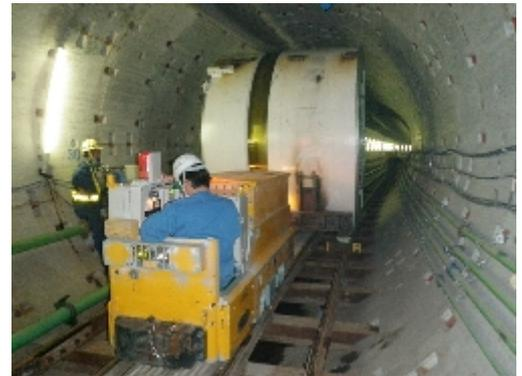
写真-1 子機坑内運搬状況
