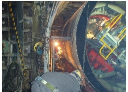
写真-2 子機を回転させながらの溶接状況
