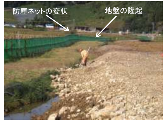
写真-2 仮置き盛土周辺の地盤変状状況
