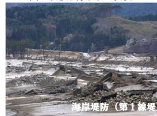
(c) 第1線堤の損傷状況
