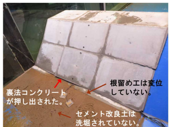
写真-1 津波越流後の裏法コンクリートの損傷状況 (透水目地ケース)
