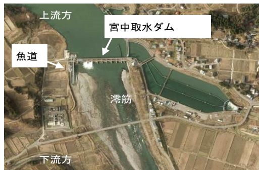
図-1 宮中取水ダム航空写真
