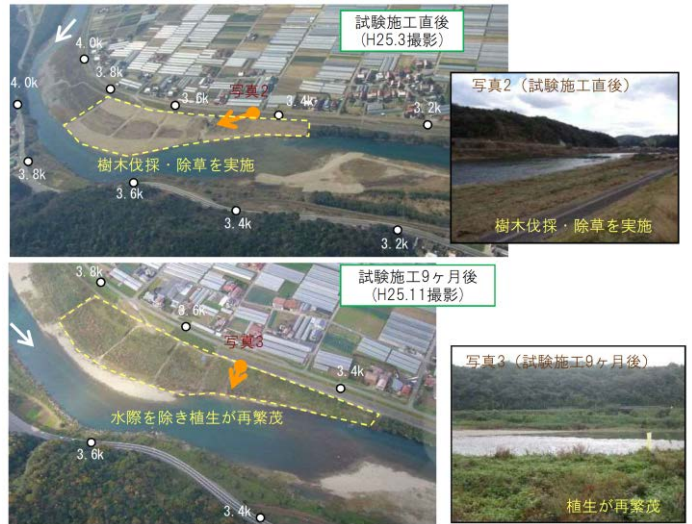
図2 掘削後の草地化
