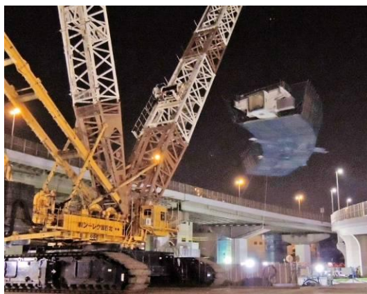
写真-1 一括架設状況
