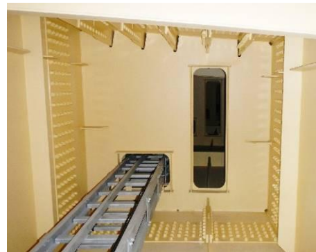
写真-2 ダイヤフラム開口形状
