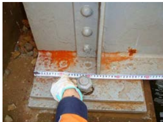
写真-1 I ビーム桁のき裂
