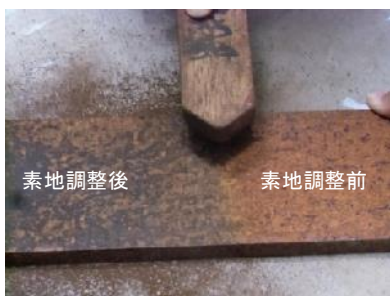
図2 素地調整状況
