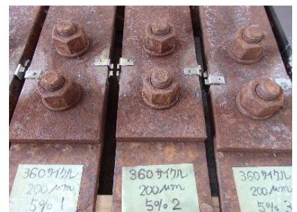
図4 腐食促進後の外観 (360サイクル)
