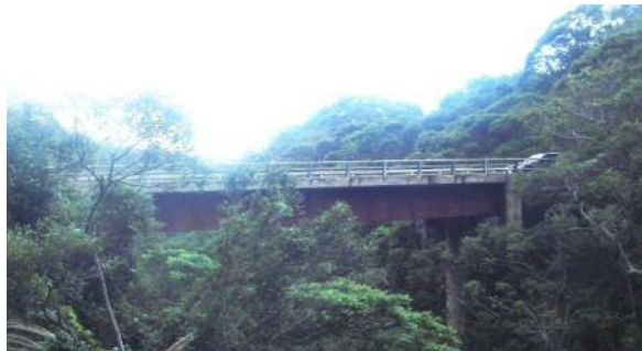
写真 1 対象橋梁の全景
