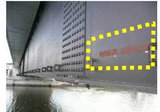
写真2 橋梁とワッペン試験片 側面配置
