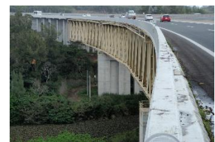
(a) ダム建設前
