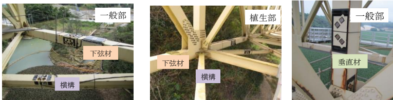
(b) 試験体の設置状況
