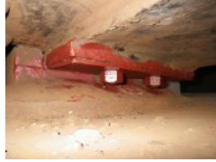
図-5 本設隙間プレート
