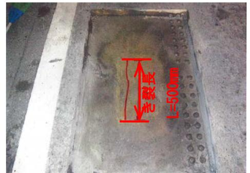
図-3 デッキ貫通き裂状況 (A橋)
