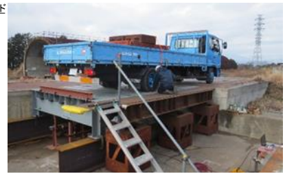
図-2 トラック载荷状況
