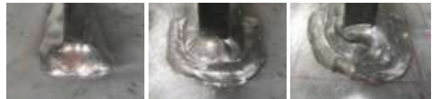
図-6 各試験体の回し溶接部
