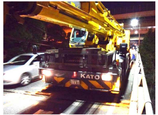
写真2 50トンラフタークレーン
