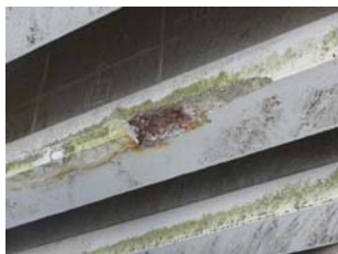
写真-2 主桁はつり部
