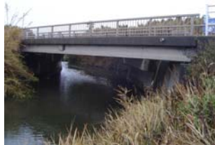
写真-1 橋梁側面
