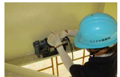
写真1 鋼材採取状況
