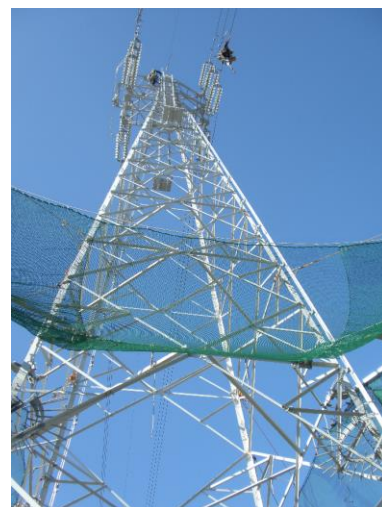
図-1 K線 No.15 鉄塔
