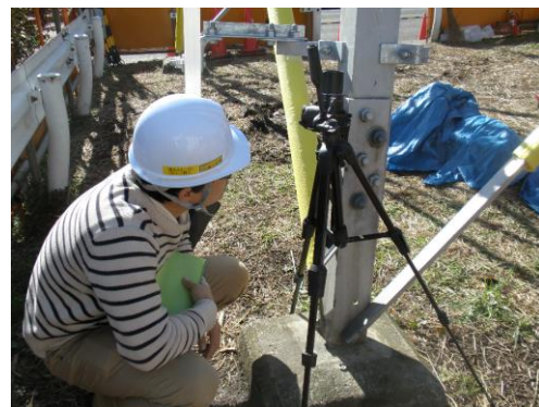
図-4 現地計測状況
