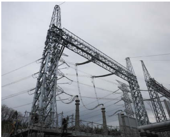
図-1 引留鉄構の外観
