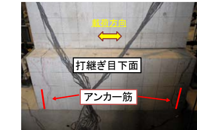
図9 試験体のひび割れ (No.3)
