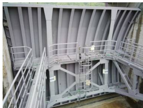
(a) 背面側から見た扉体構造
