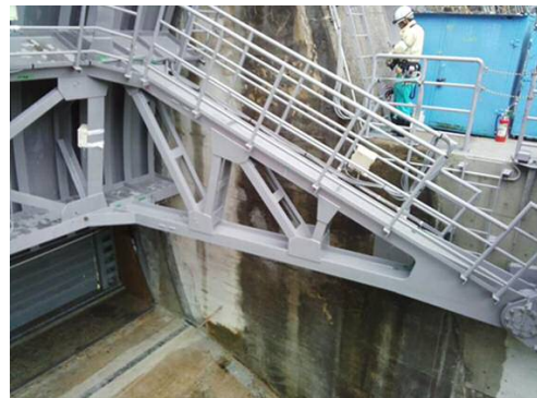
(b) N型脚柱間連結材
