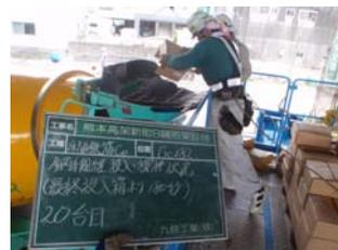
写真-3 鋼繊維投入攪拌状況
