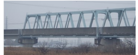
写真-1 N橋りょうの状況
