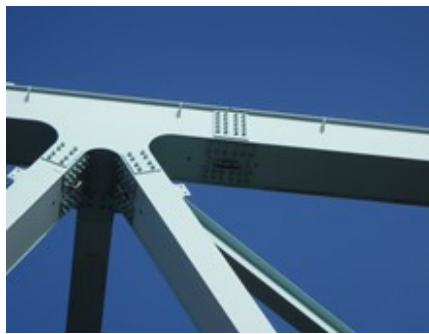
写真-2 N橋りょうの状況
