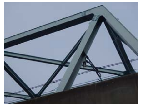
写真-3 N橋りょうの状況
