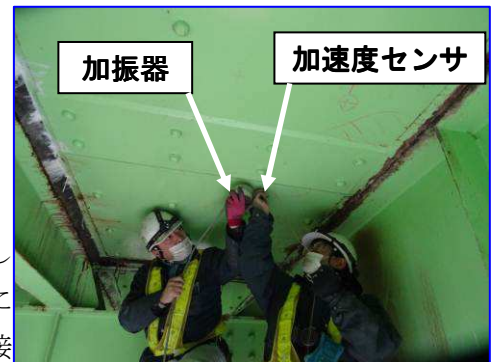
写真-2 床版下面からの計測状況
