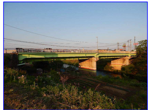
写真-1 対象橋梁
