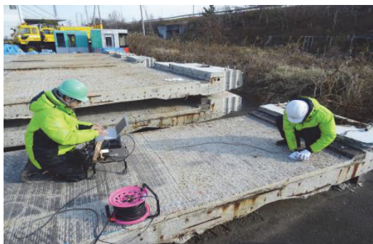
写真-1 撤去床版測定状況
