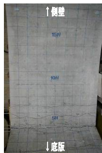
(d) 側壁基部内側
