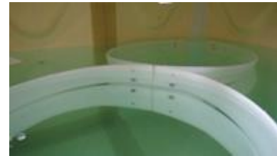
写真-1 8の字形制振装置の設置状況 L(500~5000):自在な長さで対応
