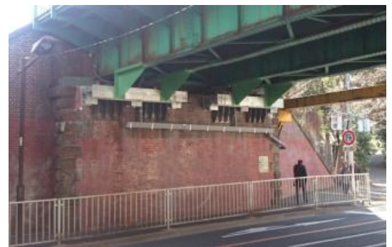
写真-2 ブラケット補強
