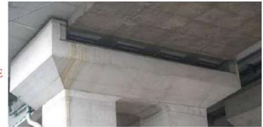
写真1 両端橋脚の機能分離支承
