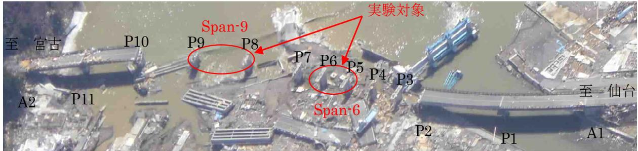
図-1 歌津大橋の被災状況
