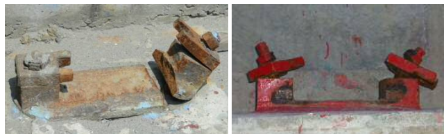
写真-1 水尻橋支承部
